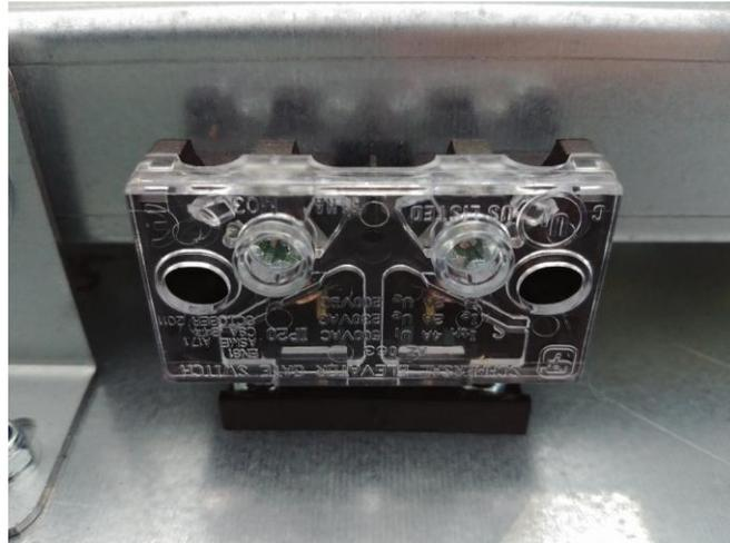
O instalador deve associar o contacto à série de seguranças da manobra para permitir que o elevador possa funcionar na manobra normal com a aba bloqueada mecanicamente na posição de repouso com o contacto fechado e permitir apenas o movimento da mesma, se forem cumpridos os restantes requisitos, na manobra de manutenção com o contacto aberto (conforme EN801/2, EN81-21 ou EN81-20)
